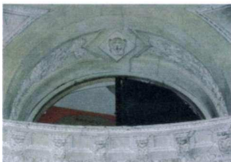
Fot 4., 5. Stan zachowania dekoracji sztukatorskiej, widoczne zacieki i przebarwienia wystroju.
