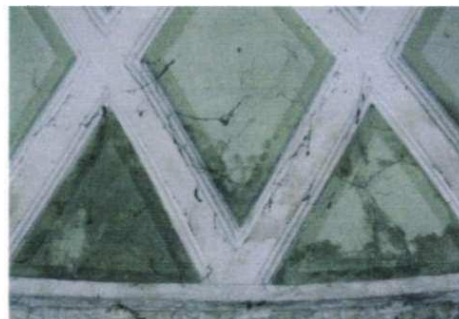
Fot 4., 5. Stan zachowania dekoracji sztukatorskiej, widoczne zacieki i przebarwienia wystroju.
